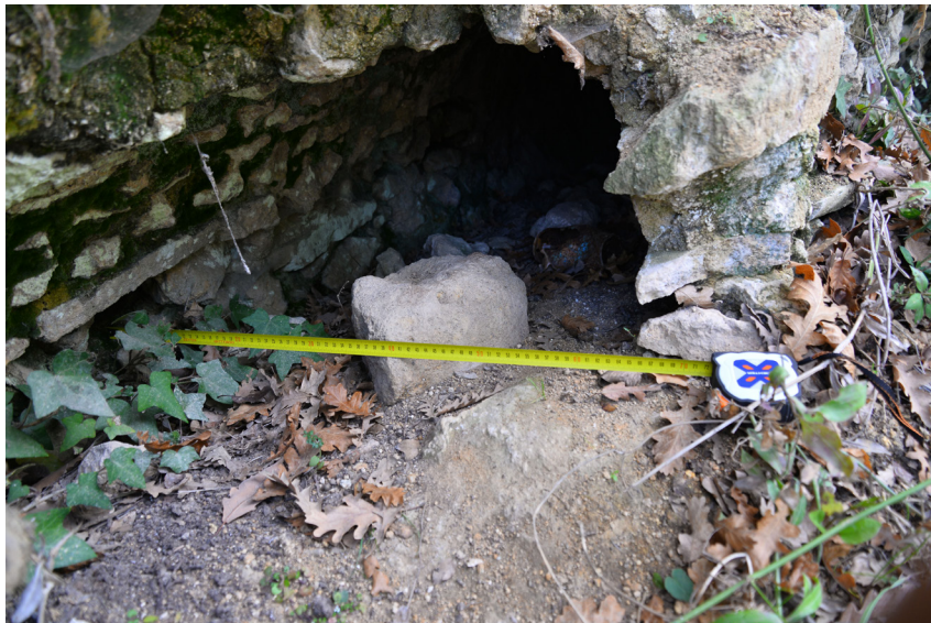
Figura 14. Tratto di canale sulla strada Allumiere – La Farnesiana, circa 250 m a NO del Ponte museo, ricostruito utilizzando conci di calcare marnoso del Flysch della Tolfa.
