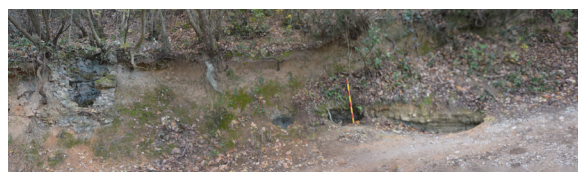
Figura 7. Tratto del canale dell'acquedotto lungo 8 m sulla strada interpoderale tra il Ponte museo e Cinque Bottini. A sinistra si vede il pozzo di ispezione. L'asta è lunga 0,80 m.
