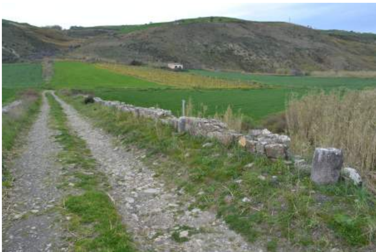
Toppo D'Aguzzo (Comune di Melfi, PZ): a) Il ponte-viadotto sulla fiumara l'Arcidiaconata; b) La carreggiata e le spalle occidentali del ponte con cippi cilindrici costituiti da calcare marnoso (foto del 5 marzo 2016)
