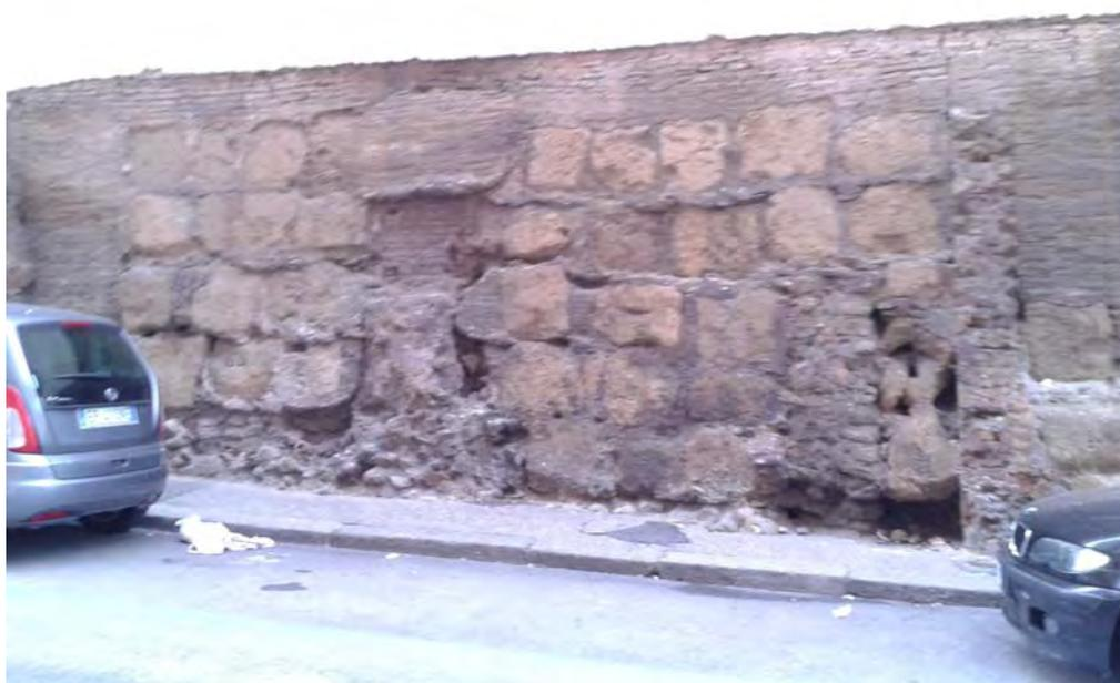
Fig. 17. – Tratto di mura serviane con conci di tufo di colore giallo tenue a Via Equizia
