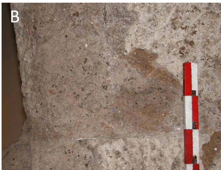
Fig. 24. – Particolare di un concio di tufo di colore grigio medio delle mura serviane di Via Salandra con frammenti di leucite, di pirosseni, di lava di colore grigio scuro, di tufi di colore giallo, di leucitite (A).
