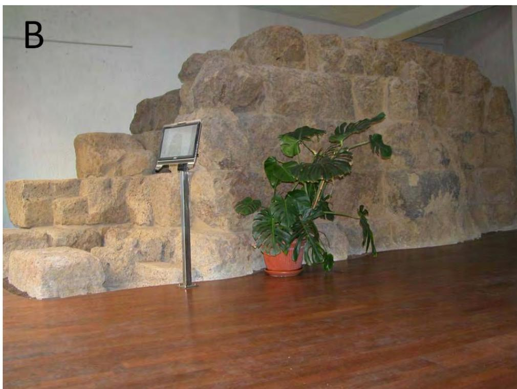
Fig. 13. – Tratto di mura serviane con conci di tufo di colore grigio medio in Via Salandra nei pressi di Via Piemonte (A) e all'interno della sede del Corpo Forestale dello Stato (B).
