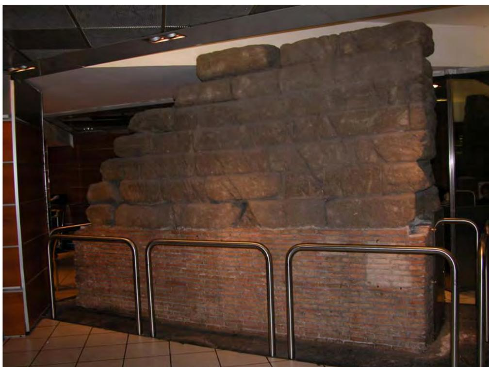
Fig. 12. – Tratto di mura serviane con conci di tufo di colore grigio medio nel sottosuolo della stazione Termini.
