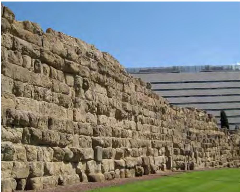
Fig. 11. – Tratto di mura serviane con conci di tufo di colore giallo tenue sul lato sinistro della stazione Termini.
