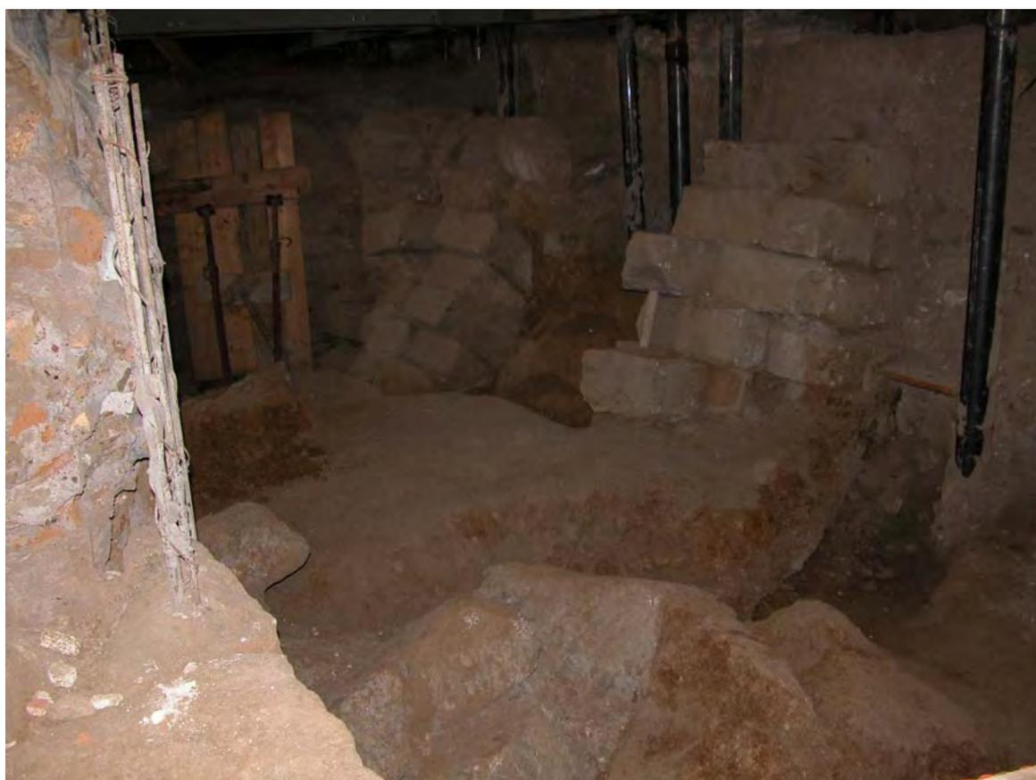
Fig. 30. – L'accumulo a sinistra di conci di tufo nello scavo dell'ex Regio Ufficio Geologico indica che un piccolo tratto di mura ha subito un modesto dissesto localizzato.
