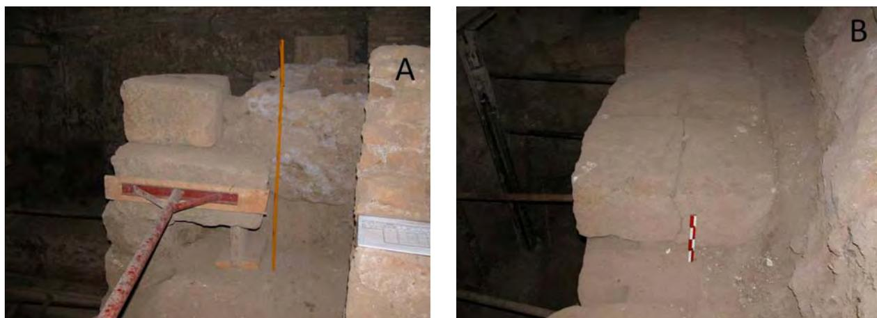
Fig. 29. – Tratto di mura con conci di tufo di colore giallo tenue esternamente nello scavo al primo piano dell'ex Regio Ufficio Geologico (A).
