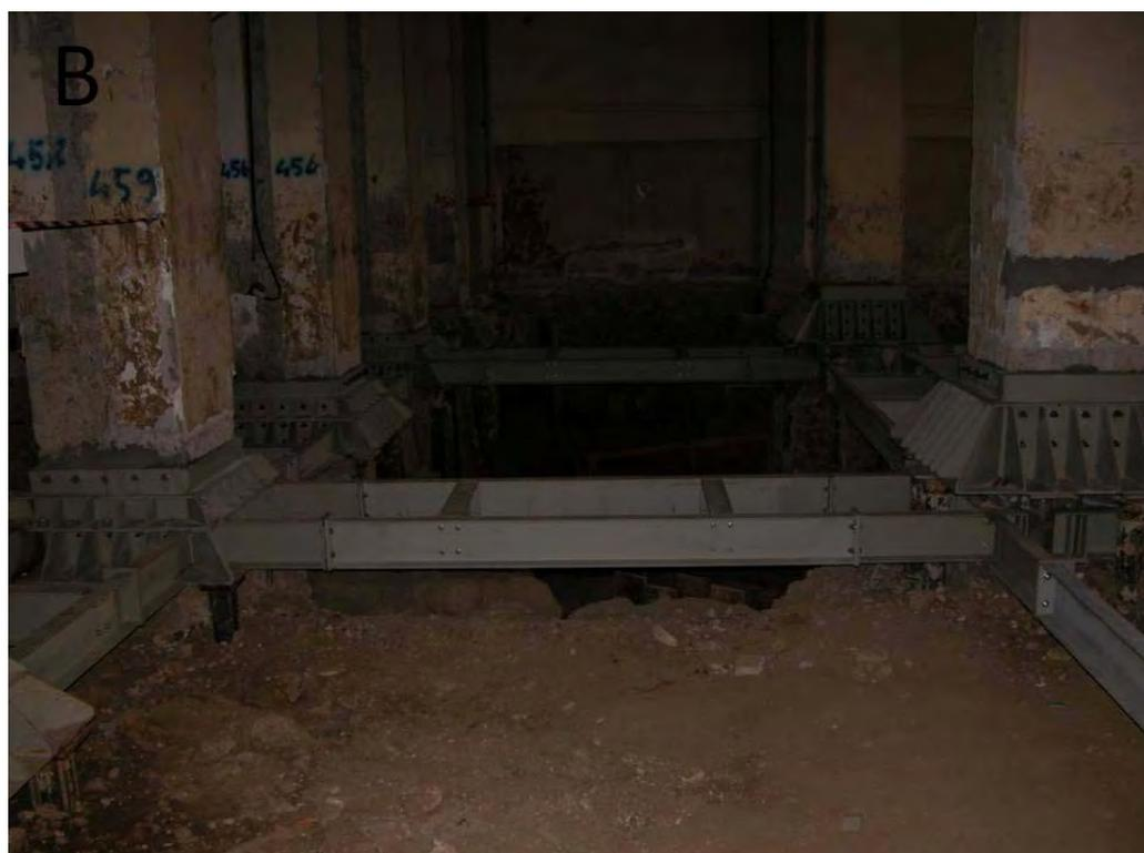
Fig. 28. – Veduta della rimozione del piano di calpestio propedeutica allo scavo per il ritrovamento delle mura nel sottosuolo del primo piano dell'ex Regio Ufficio Geologico (A).
